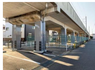
高架橋の耐震補強
