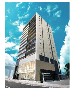
● 地中熱ヒートポンプ採用住宅
