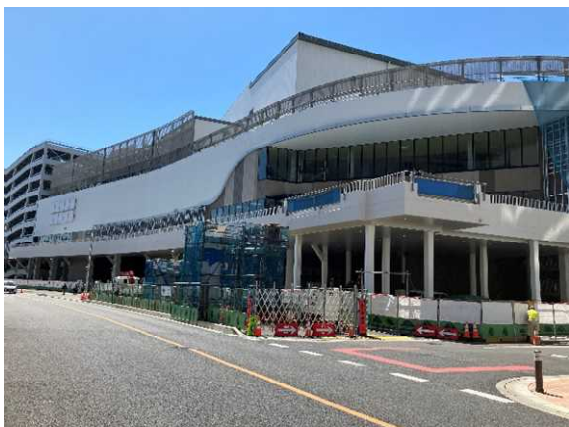
エミテラス所沢外観（2024 年 4 月 10 日撮影）
