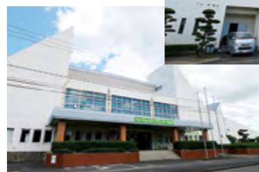
マルマエスポーツセンター出水
