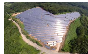
鳩山太陽光発電所
