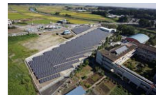
小山太陽光発電所
