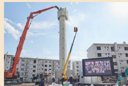
解体工事の様子
