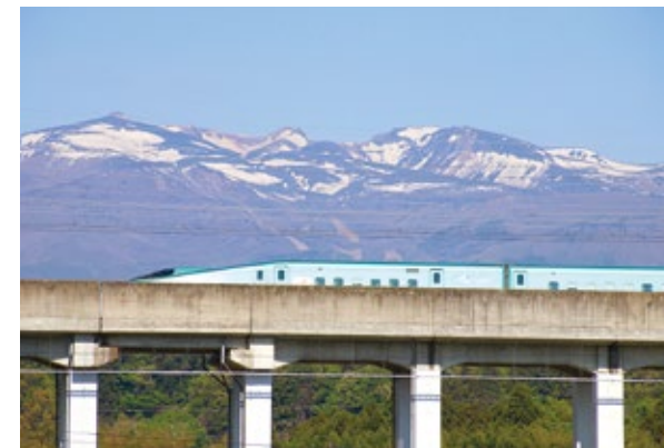
東北新幹線の高架橋(福島県内・特殊混和材)
