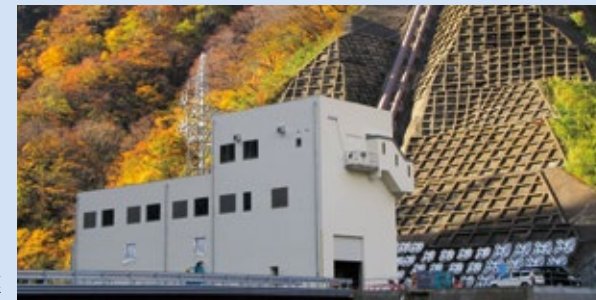
2021年1月に送電を開始した デンカの新青海川発電所
