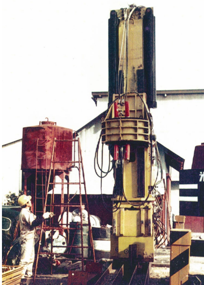
1号機の初めての試験施工の様子
