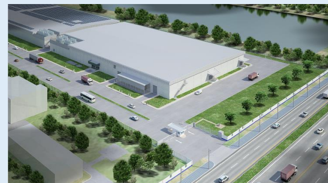
多目的工場 (タイバンパイン工場内)
