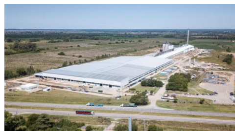
アルゼンチンの新フロートライン（建設中）
