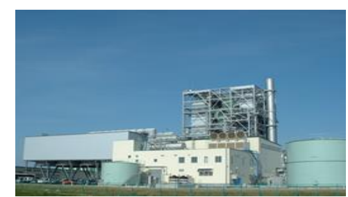
【 苫小牧発電所 】
