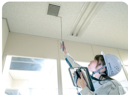
外部計測機器の風量計を用いた風量測定検査の様子
