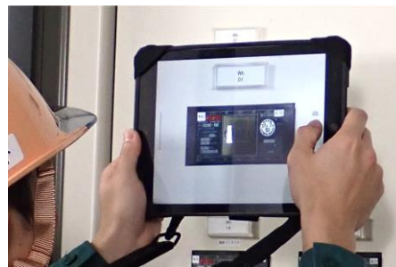
画像左：電力計を読み取る作業の例 (画像提供：株式会社きんでん)
