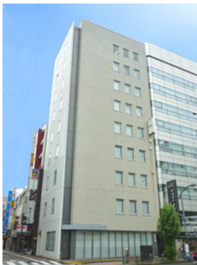
(写真：(仮称)蒲田東口ビル)
