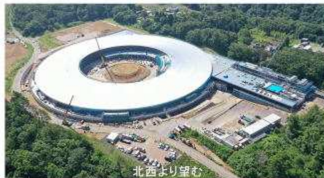
次世代放射光施設建設工事 2021年7月16日上空写真
