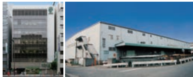
ウインズ梅田A館ビル 1982年竣工 枚方倉庫 1983年竣工
