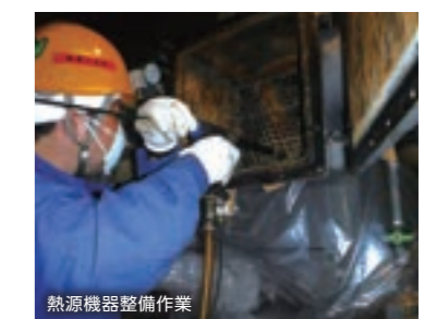
熱源機器整備作業
