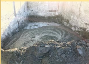
泥状の生コンクリート
