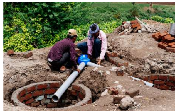
「SATO Vトラップ」を施工する様子
