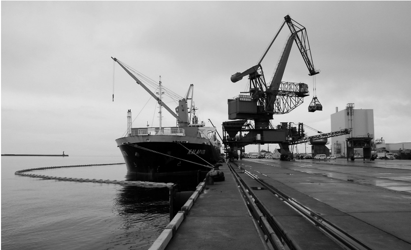
2021年6月、伏木港にバイオマス発電用の木質燃料船が初入港しました。
