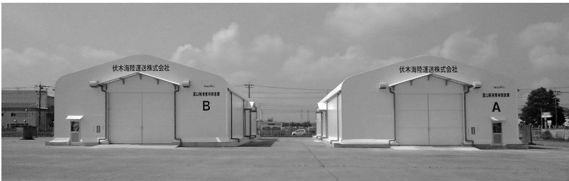
2021年6月、富山新港に木材専用倉庫2棟が完成しました。
