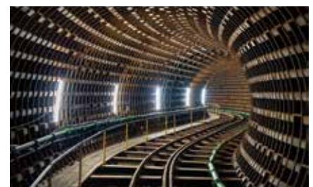
シールドトンネル内(曲線区間)
