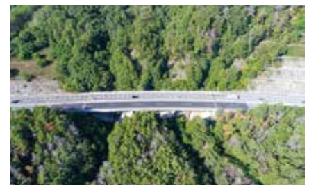
長野自動車道虚空蔵橋(下側が上り線)
