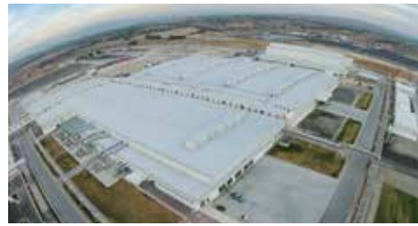
ホンダメキシコトランスミッション工場 (メキシコ) 2014年 建設当時、メキシコでの最大の自動車工場、日本の設計仕様のメキシコ仕様化と大規模工事を13か月で完成
