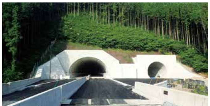
完成した坑口
