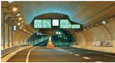
首都高速中央環状川線大橋連結路 (東京都) 2014年 並行する2本のシールドトンネルを開削せずに切り開く世界初の工法「セグメントによる非開削切開き」工法を採用 2014年度土木学会技術賞
