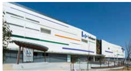
三井ショッピングパーク ららぽーと富士見 (埼玉県) 2015年 設計施工で手がけた東武東上線エリア最大級のショッピングモールであり、施工段階では効率化・省力化を図り、約1年4か月という短工期を実現
