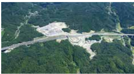
第二東名高速道路 岡崎サービスエリア (愛知県) 2015年 高速道路本線および岡崎サービスエリアの施工に伴う、切盛土量380万m 3 の大規模土工事と本線全域における法面補強対策工事
