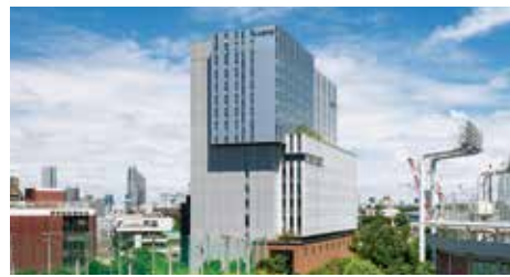
日本青年館・日本スポーツ振興センタービル (東京都) 2017年 劇場、ホテル、事務所などを備えた大規模複合建築物で、メガトラス梁のリフトアップ工法を採用
