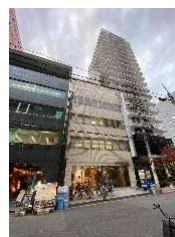
大和本町ビル
