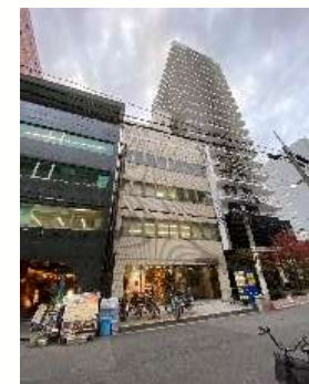
大和本町ビル
