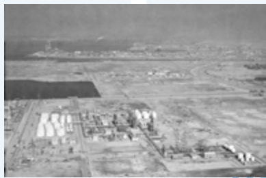
日産石油化学千葉工場(1968年頃)
