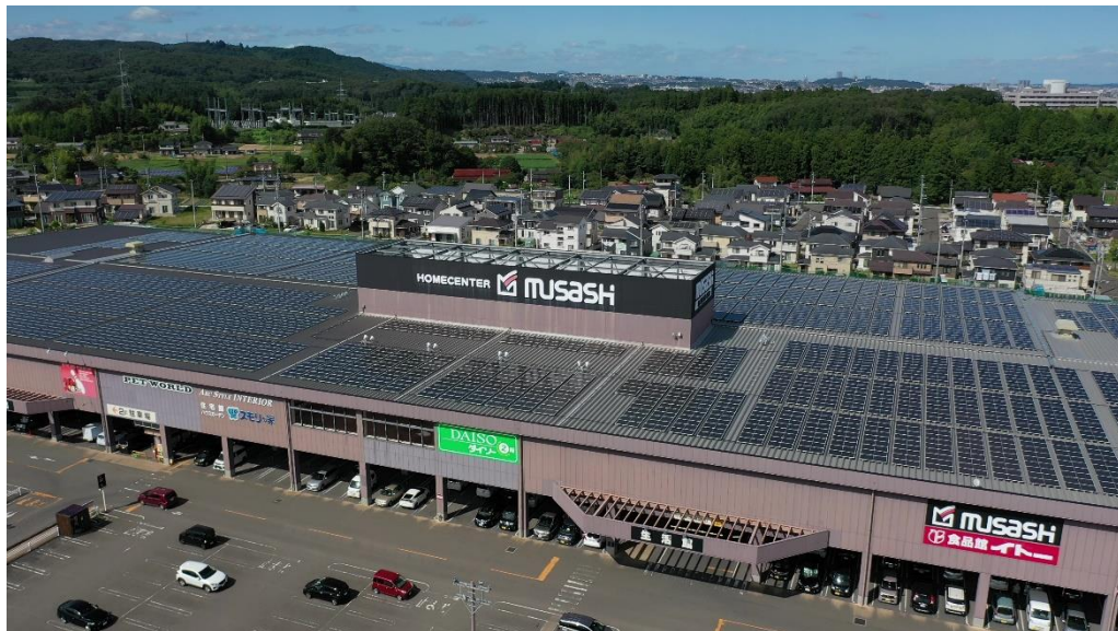
ホームセンタームサシ名取店に設置した太陽光発電システム
