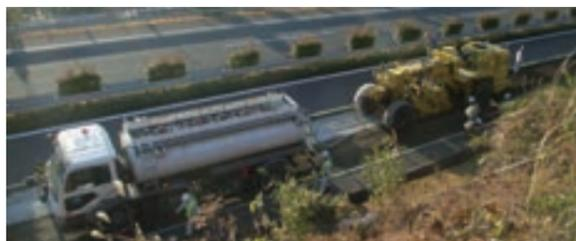
スタビセメントRC工法(ディープスタビライザーによる混合状況)
