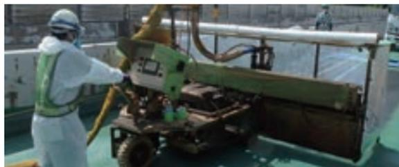
HQハイブレンAU工法(バインダー散布ロボットによる施工状況)
