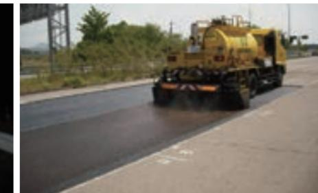
夜間・低温時もすぐに分解し、舗装同士をしっかりと接着させる「スーパータックゾール」
