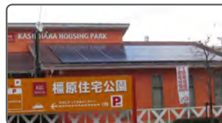
センターハウスの屋根に設置された太陽光パネル
