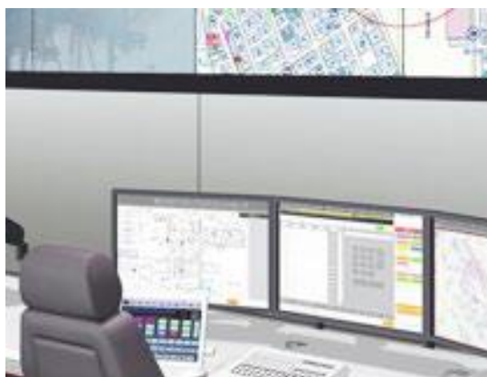
消防システム
