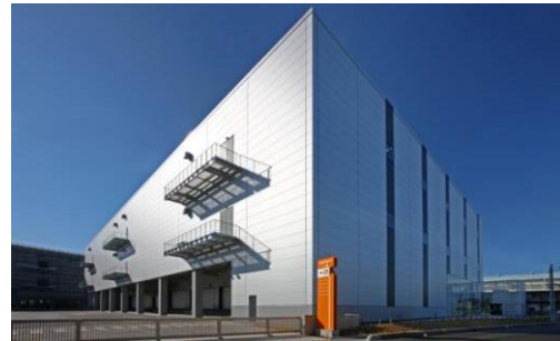
2 ロジスクエア八潮 2014年1月竣工
