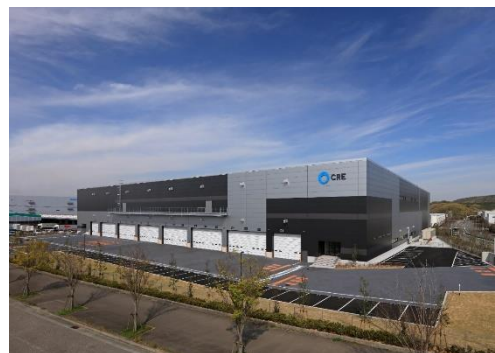
16 ロジスクエア神戸西 2020年4月竣工
