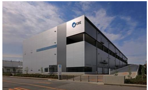
4 ロジスクエア久喜 2016年6月竣工
