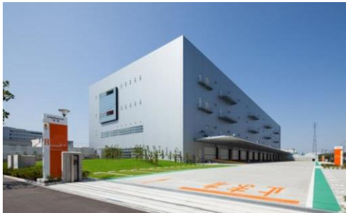
1 ロジスクエア草加 2013年6月竣工
