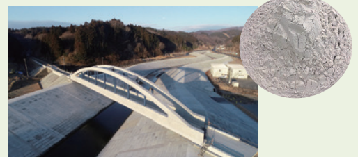
JR気仙沼線桜川橋梁(宮城県本吉郡南三陸町)橋桁、アーチ部、縦鋼にCfFA®を使用
