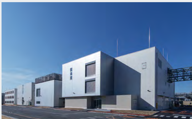
第3実験棟(小山工場内)
