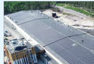
屋根一面に太陽光発電パネルを設置したコマツフォレスト新工場(2021年8月竣工、スウェーデン・ウメオ)
