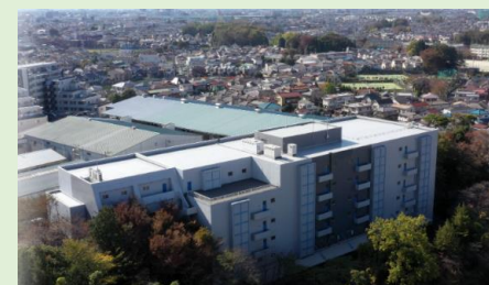
東京第一物流センター
