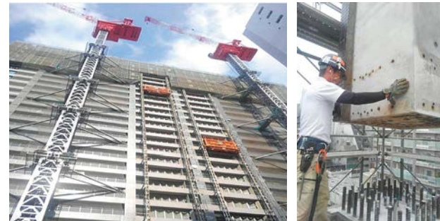
PCa工法で作業の効率化、省力化により工期短縮を実現
