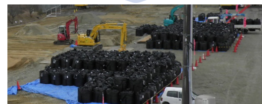
フレコン（黒袋）に放射性廃棄物を入れて一時保管を行う
