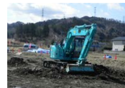
放射性物質が付着した地表部分の土を削り取る作業
