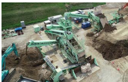
回転式破碎混合工法（ツイスター）
