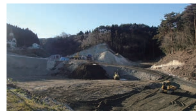
2015年 松島どんぐり太陽光発電所の造成工事
