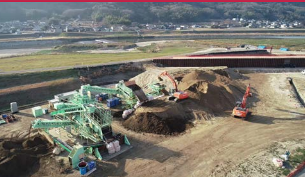
河川堤防の切り札「回転式破碎混合工法®」 (通称：ツイスター®)
