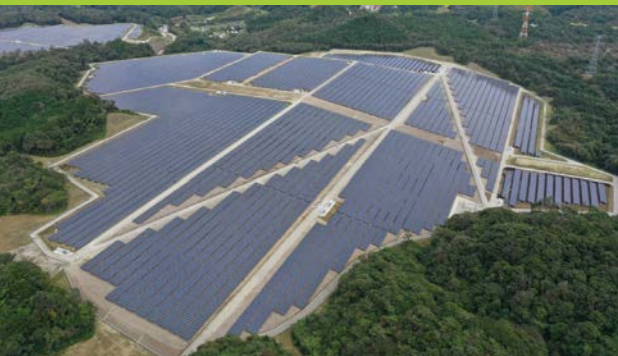
2020年12月から売電を開始した 松島どんぐり太陽光発電所
