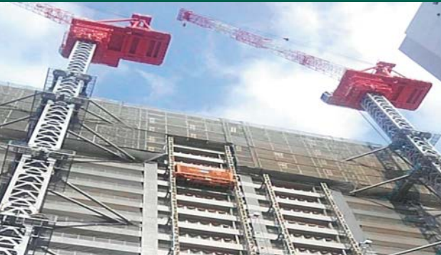
プレキャストコンクリート工法 (PCa工法) による施工の様相
