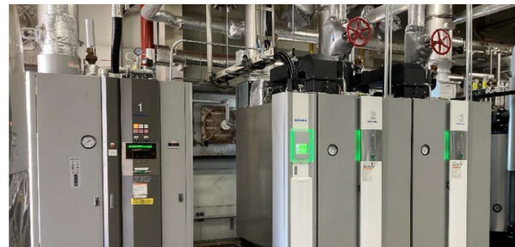
不要な油を工場内の燃料として 有効活用できるボイラーを導入(鹿島油脂工場)
