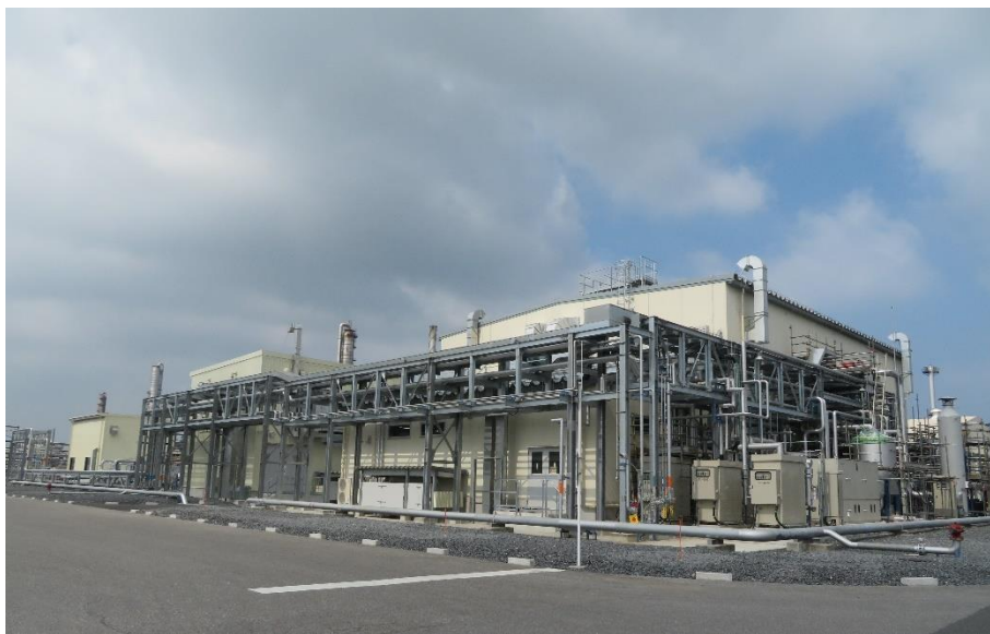
商業生産に向けた実証設備の建屋外観
