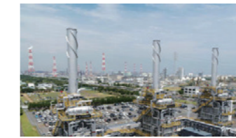
100MW級コンバインドサイクル発電プラント
