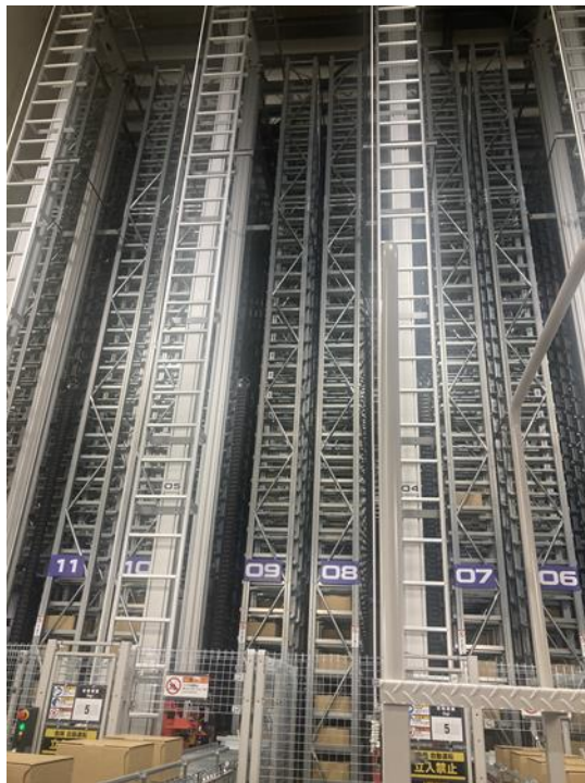
製品倉庫棟内部
