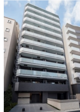
マンション施工事例
