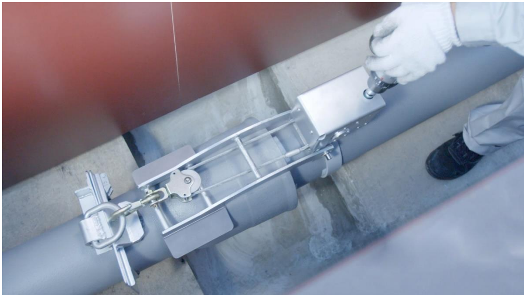
(「楽ちゃく」を使った接合作業の様子、電動ドライバーなどで簡単に接合が可能)
