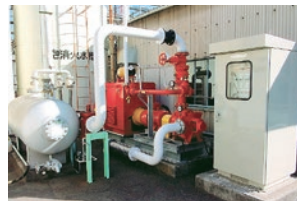
泡消火ポンプ更新
