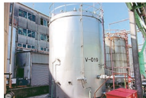
スチレンタンク更新
