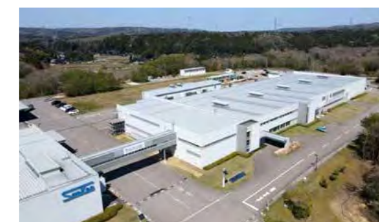
▲堀松工場B棟・先進技術推進センター 延床面積:10,253.25m 2
