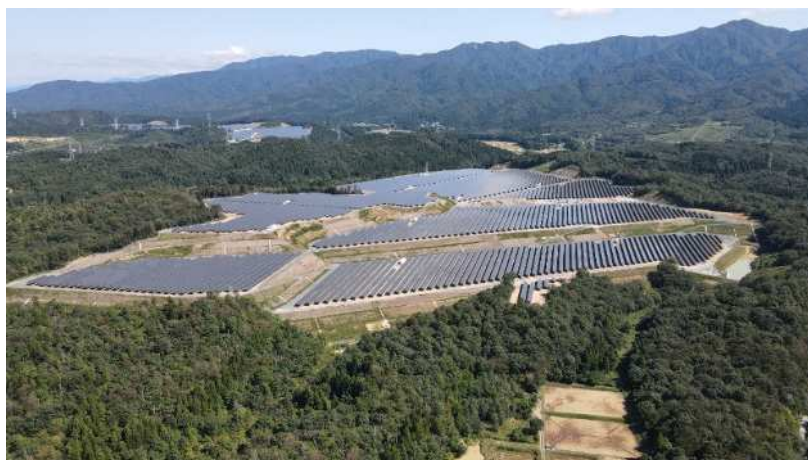
<大室メガソーラー発電所 全景写真>
