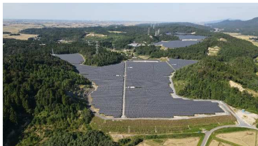
<大日メガソーラー発電所 全景写真>
