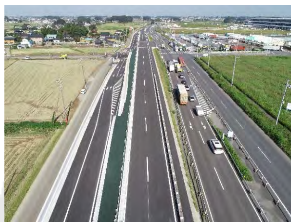
R2新4号幸主地区舗装工事
