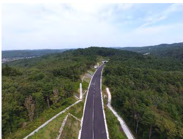
国道45号宇部芦ヶ沢地区 舗装工事
