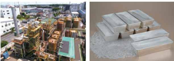
廃液濃縮・高温酸化処理設備 (MCRシステム)
