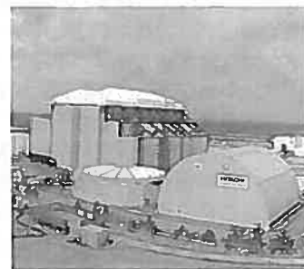
大間原子力発電所の建設状況
