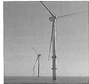
トライトン・ノール洋上風力 (建設中・85.7万kW・イギリス)
