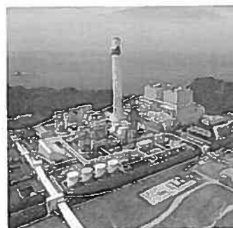
松島火力発電所 (100万kW・長崎県)
