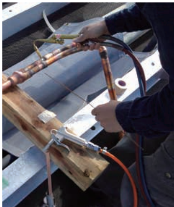
エルブレイズ工法施工状況
