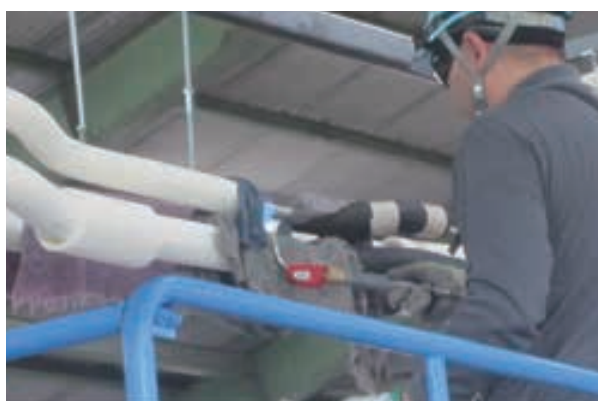
アルミ管のろう付施工状況
