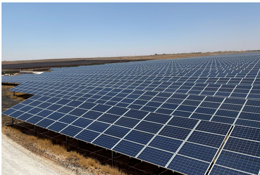
ヨルダンの蓄電池併設太陽光発電プロジェクトであるAl Badiyaプロジェクト
