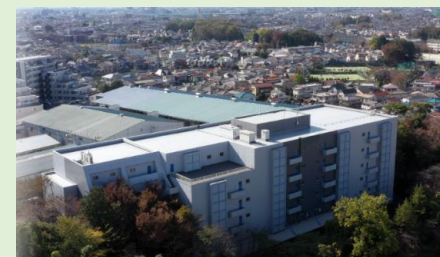
東京第一物流センター
