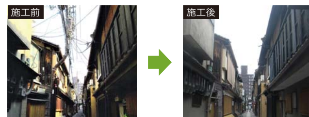
先斗町無電柱化工事
