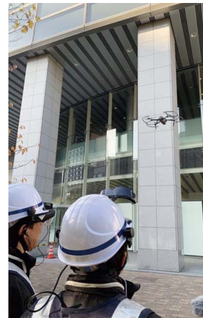
ドローンとARスマートグラスを活用したビル外壁点検
