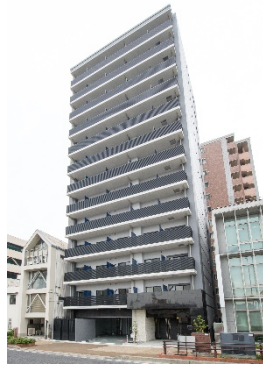
26. S-RESIDENCE 四日市元町
