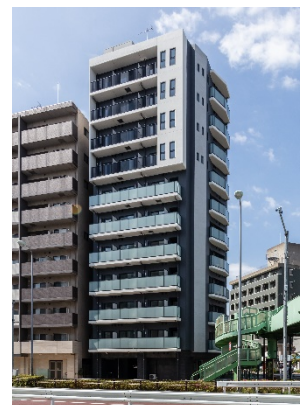
12. S-RESIDENCE 王子 west
