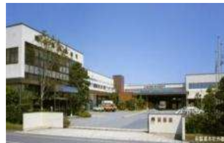
寿製菓(株) 本社工場
