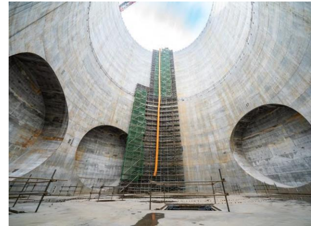
梶ヶ谷非常口
