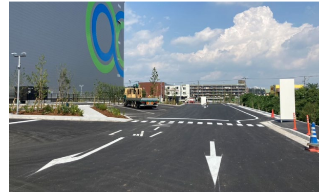
廃PETを用いた高耐久アスファルト改質剤の 展開が拡がり、大手物流会社でも採用
