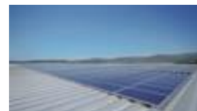
太陽光パネルの設置
